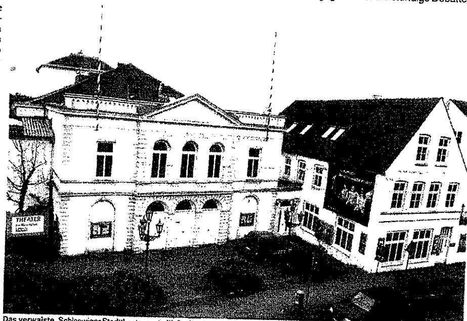
Das verwaiste Schleswiger Stadttheater am Lollfuß mit seinen Nebengebäuden
